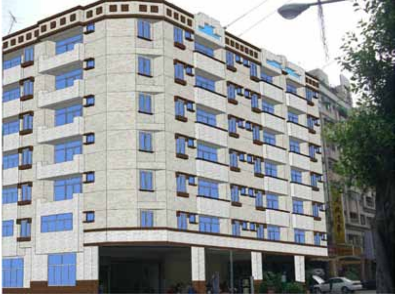
外牆以仿米白石材之淡色，並局部搭配印度紅暗色，打造全新建築物外觀
