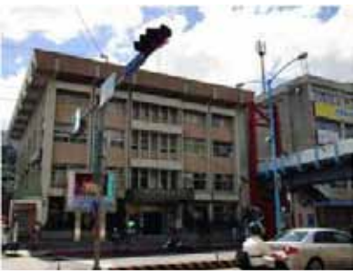
更新前建物為公務機關 (上)警察局新店分局(下)新店區公所
