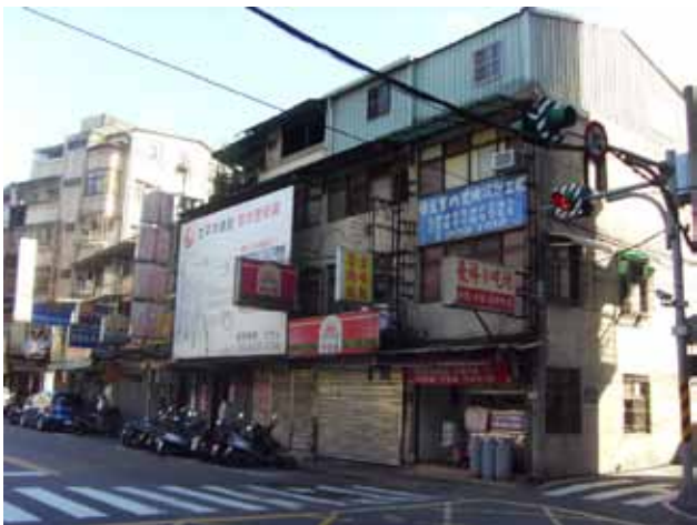
老舊建築緊鄰計畫道路，缺乏人行空間
